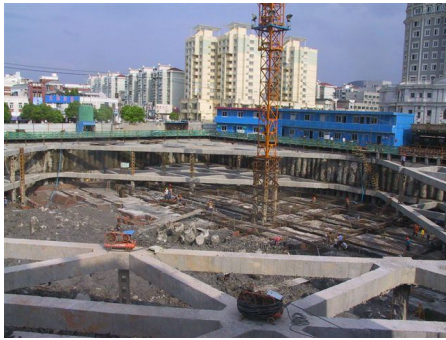
图 13 基坑实例概貌
